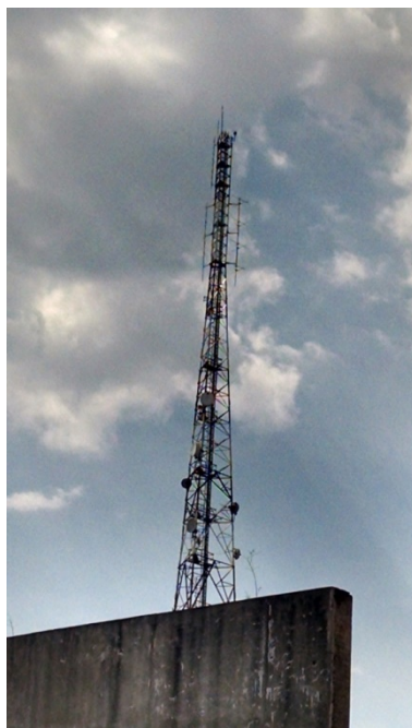
Imagen 42. Antena de Aguas Argentinas desde la cual transmitía la señal de IPESA . A los laterales de la antena, luego de la sección inicial, pueden observarse ambas antenas dipolo.
