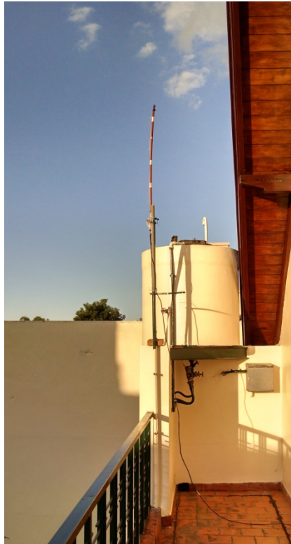
Imagen 41. Antena dipolo de EMISION / DIFUSION , basada en el instructivo de Tetsuo Kogawa, montada en el techo de la residencia Plano.
