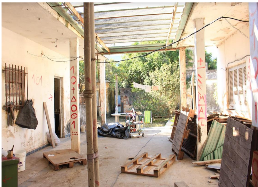
Imagen 12. Vista general del estado de la casa abandonada que restauramos y acondicionamos para montar las salas de Juegos de Escape Resistencia.
