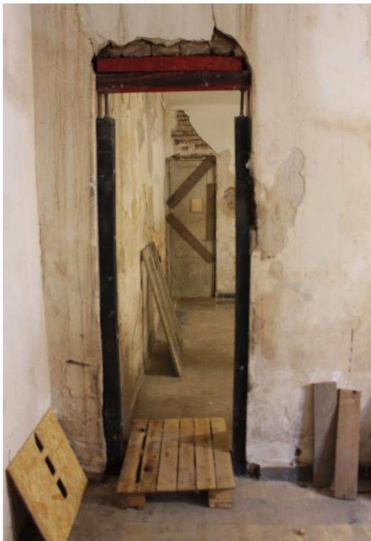
Imagen 13. Refacciones en aberturas vencidas.
